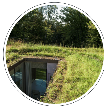
zelené střechy extenzivní / polointenzivní, přechod do stávajícího terénu
